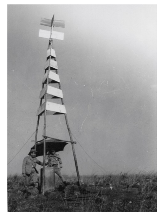
Vértice PAQUITO reconstruído e sinalizado para medição angular.
