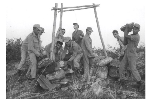
Fixação dos pés da pirâmide sobre o vértice MANOEL FIGUEIREDO
