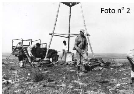
Fixação dos pés da pirâmide sobre o vértice MANOEL FIGUEIREDO
